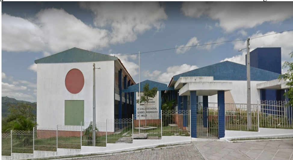
Figura 2: Fachada da Escola Estadual de Ensino Fundamental e Médio Isabel Rodrigues de Melo
